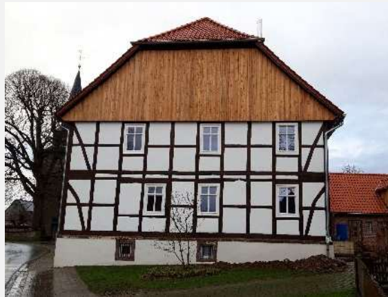
neue Holzverschalung im Giebeldreieck
