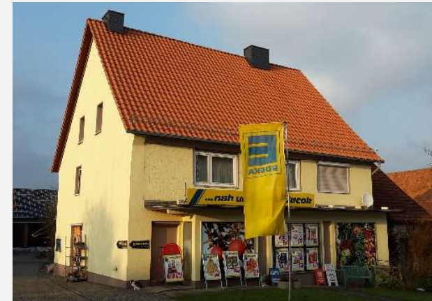
neue Dacheindeckung, naturroter Hohlfaalziegel
