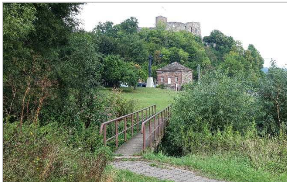
Die Lonaubachbrücke bei Polle
