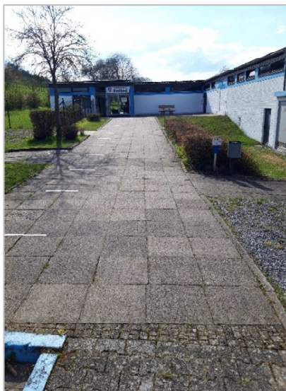
Weg zum Eingang des Freibades
