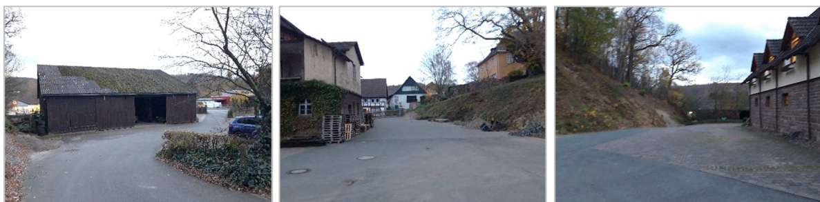
Eindrücke vom jetzigen Zustand und Entsiegelungsgrad des Grundstücks Heinser Straße 1
