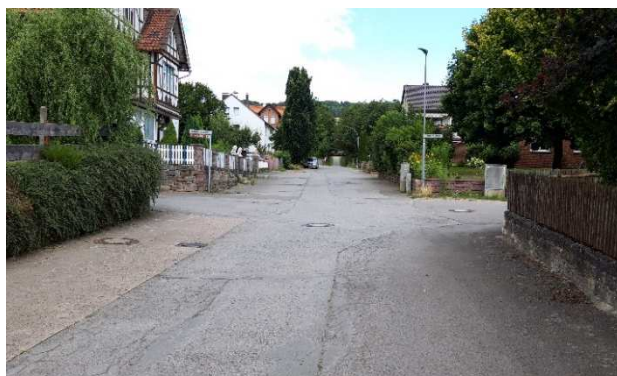
Die Straße Neues Tor ist vollflächig versiegelt
