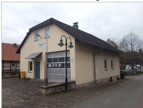
Massivbau der 1980er Jahre
