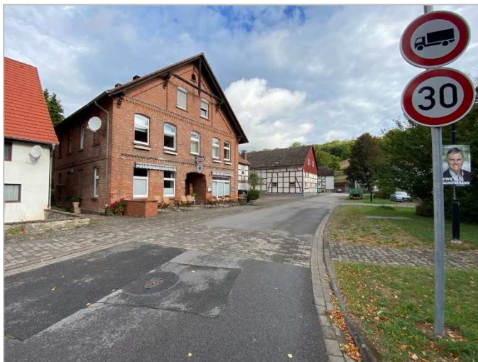
Blick auf den Verlauf der Glessestraße Richtung Norden
