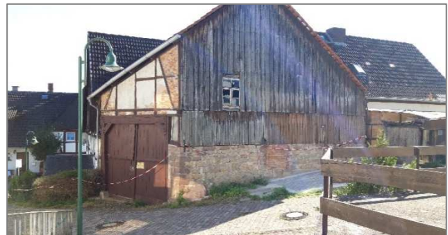
Ansicht von der Bergstraße aus
