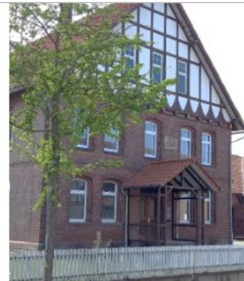
**Beispielhafte Sanierung:** weiße Holzfenster (zweiflügelig mit Unterteilung), passende Türvorbauten (offen und geschlossen)
