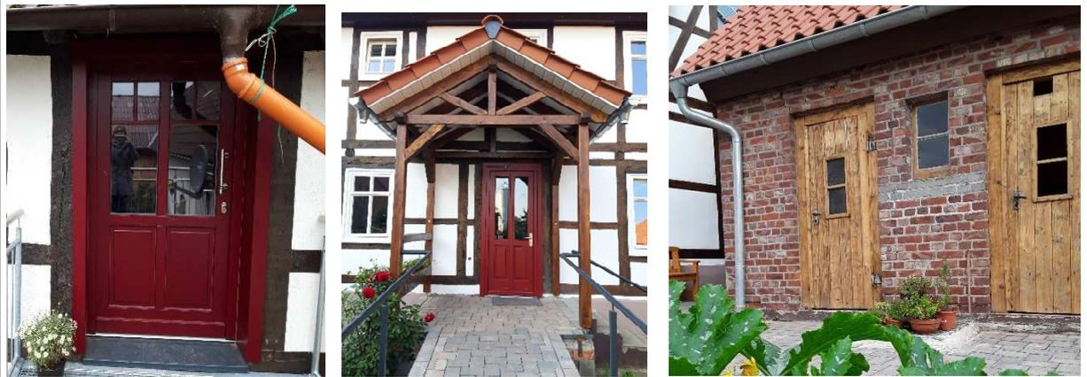
**Beispielhaft und neu:** Hauseingangstüren aus Holz mit Kassetten und Glaseinbauten
