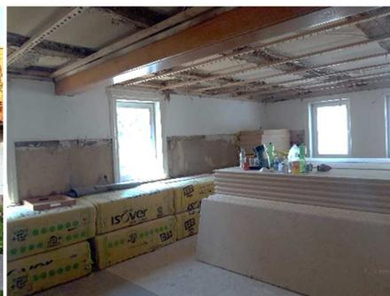
Erhalt des nach außen sichtbaren Fachwerks durch Innendämmung
